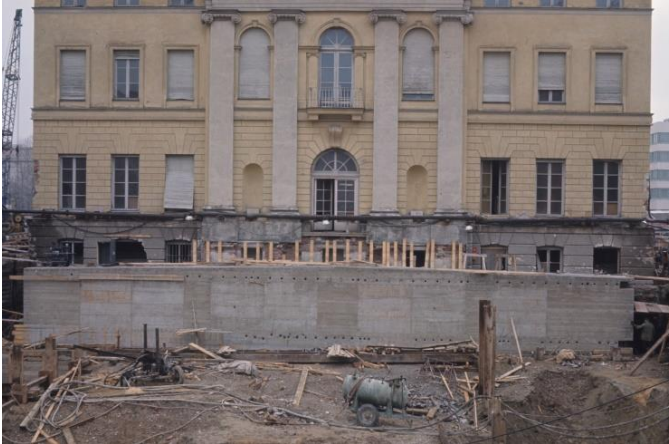
Abb. 1: Errichtung der Tunneldecke im Kellergeschoß des Prinz-Carl-Palais, Foto: Landeshauptstadt München
