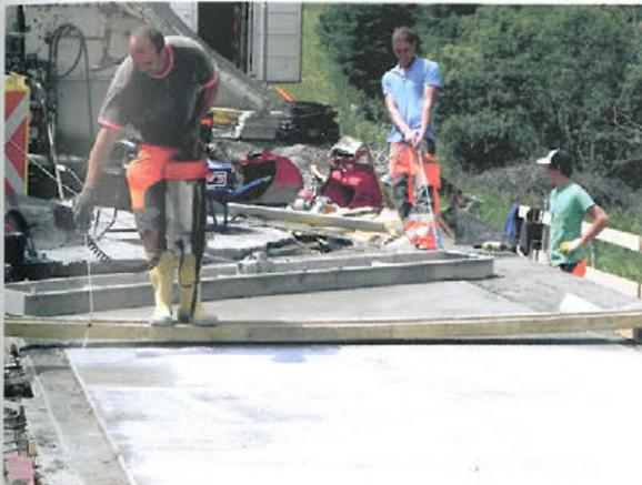
**Bild 7.11:** Auftragen des Verdunstungsschutzes (BA1) [7] (Foto: Mario Hansl)
