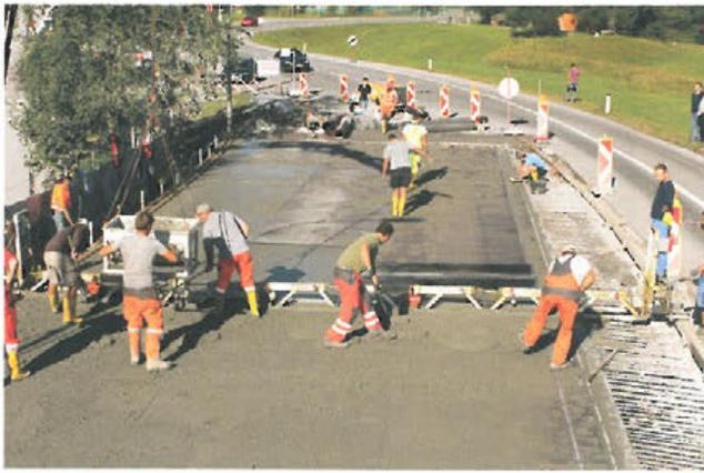
**Bild 7.16:** Gesamtübersicht Herstellung Textilbeton (BA1) (Foto: Gerhard Umfer)
