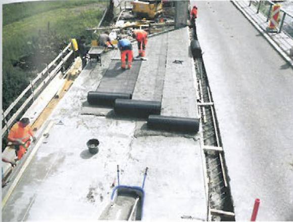
**Bild 7.9:** Verlegen der textilen Bewehrung (BA1) [7]
