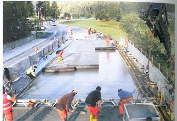
**Bild 7.19:** Gesamtübersicht, Herstellung Textilbetonschicht (BA2) (Foto: Mario Hansl)
