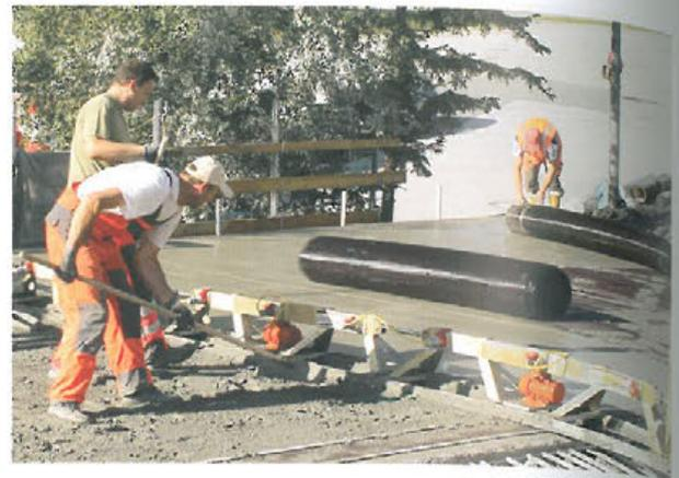
**Bild 7.17:** Arbeiten mit Abziehbohle (BA1) (Foto: Mario Hansl)
