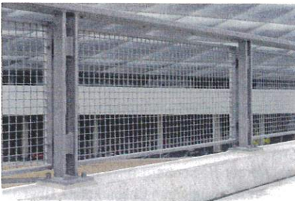
Geländerdetail © CBP Ingenieurbau GmbH
