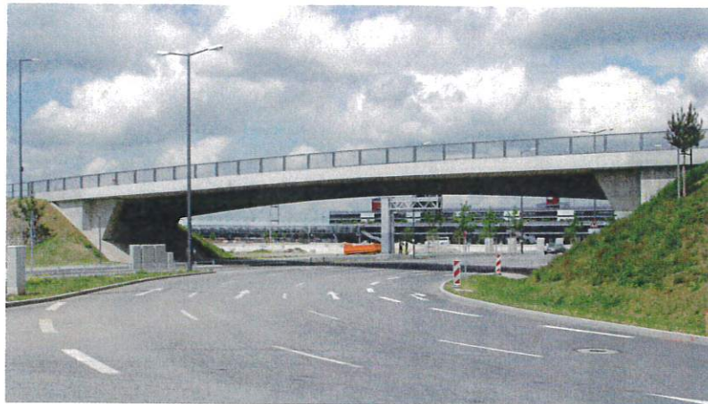
Verbundbrücke als Rahmen (1) © CBP Ingenieurbau GmbH
