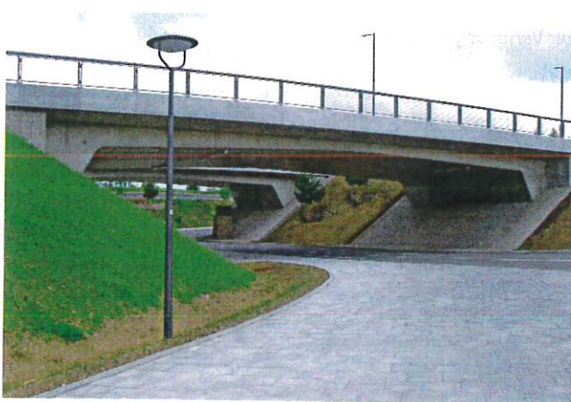
Zwei Spannbetonrahmen (3) © CBP Ingenieurbau GmbH
