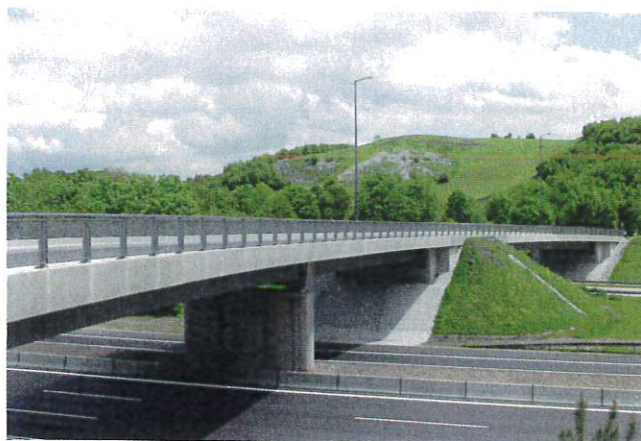
Brückenzug vom Stadion über die A 9 (7) © CBP Ingenieurbau GmbH
