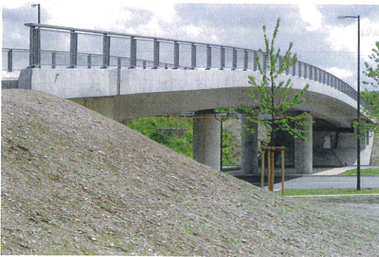
Spannbetontragwerk (8) © CBP Ingenieurbau GmbH
