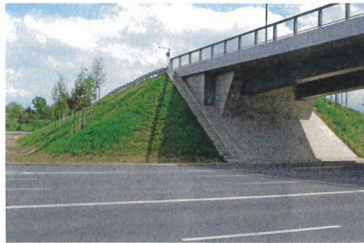
Zurückgesetzte Widerlager © CBP Ingenieurbau GmbH
