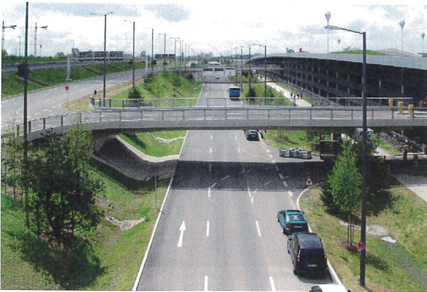
Drei Brücken zur Parkhausanbindung (4) (5) (6) © CBP Ingenieurbau GmbH
