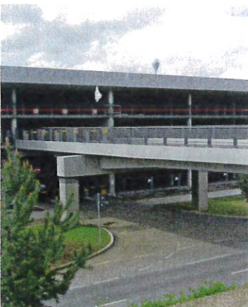
Spannbetonjoch ... © CBP Ingenieurbau GmbH
