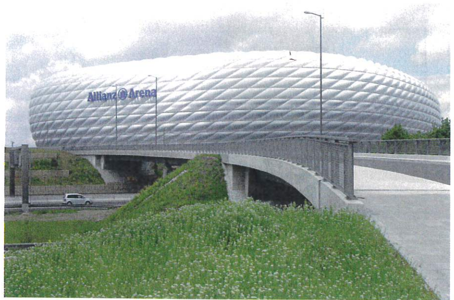
Stadion mit Brückenzug © CBP Ingenieurbau GmbH
